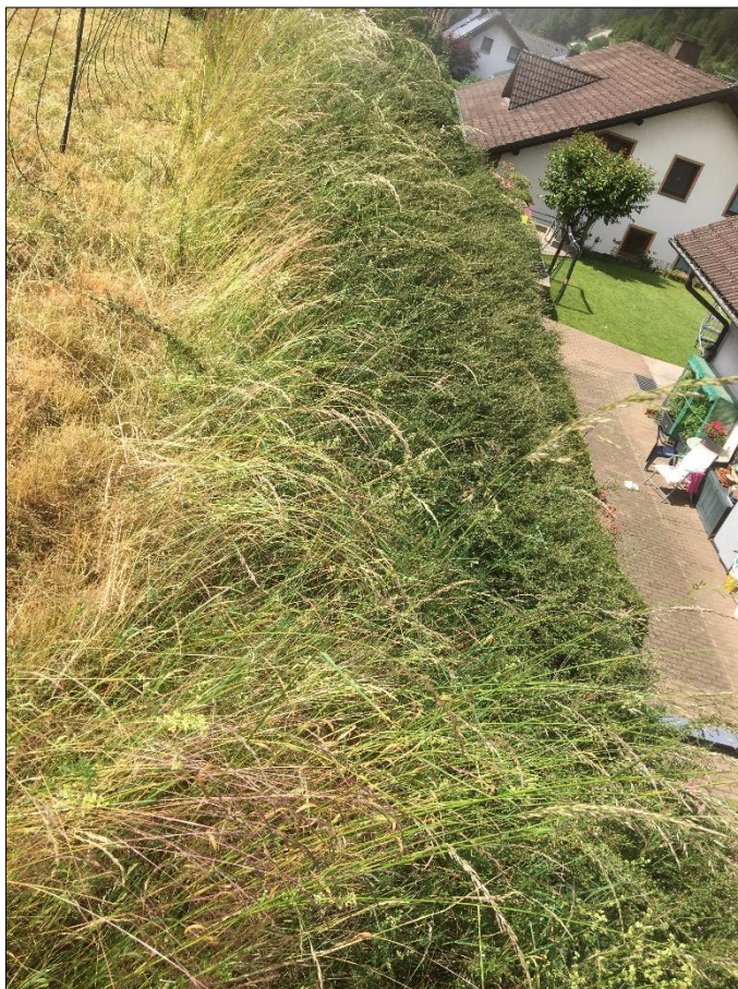
Abb. 4: Böschung hinter dem Haus und angrenzender Zierrasen
